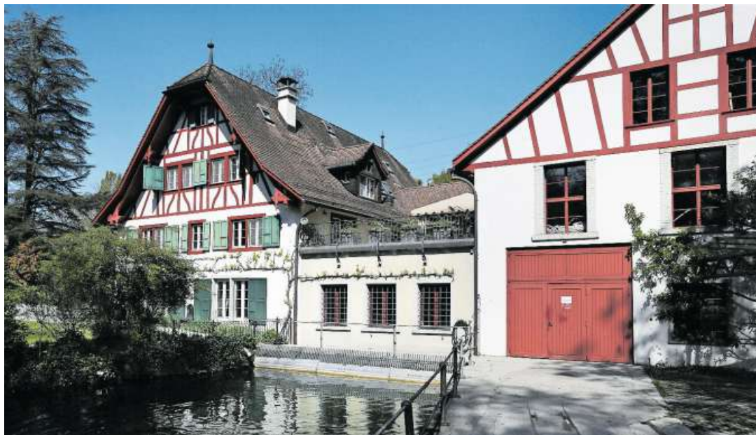
Das Kleinwasserkraftwerk Hammer in Cham. Das Bild zeigt das Gebäude, in dem sich die Turbine befindet. Wie es mit dem Werk weitergeht, ist ungewiss. Bild: Stefan Kaiser (Cham, 21. April 2017)
